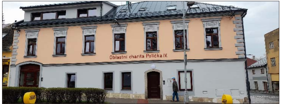
Pohled na rekonstruovaný CHD IV. z Vrchlického ulice
